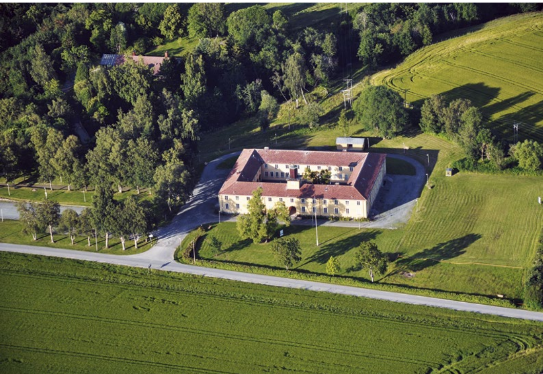
➤ Bilde 2 Dronefoto fra 2019 av Falstadbygningen og det tidligere leirområdet.
